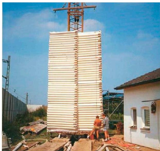
Рис. 1. Устройство виброзащитного и противофильтрационного барьера из газонаполненных баллонов, погружаемых в траншею, выполненную методом «стена в грунте»
