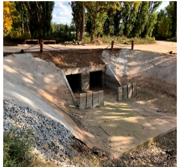
Рис. 1. Общий вид водовода прямоугольного сечения (фото авторов, 2021 г.)
